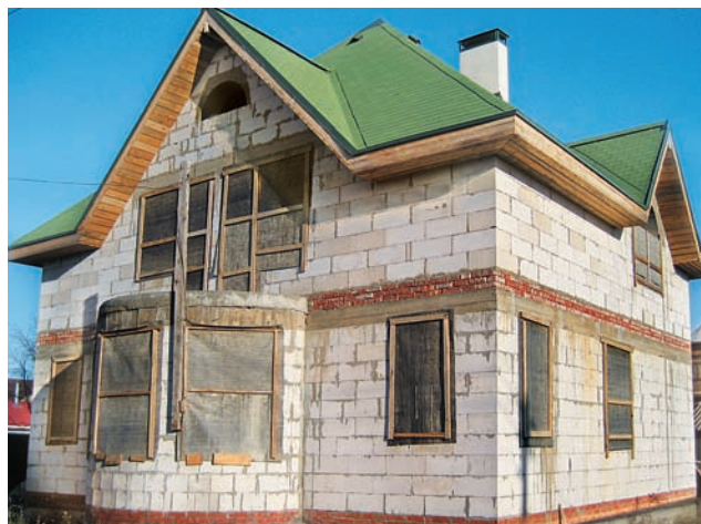
Дома из пеноблоков тоже нередко дополнительно утепляют
